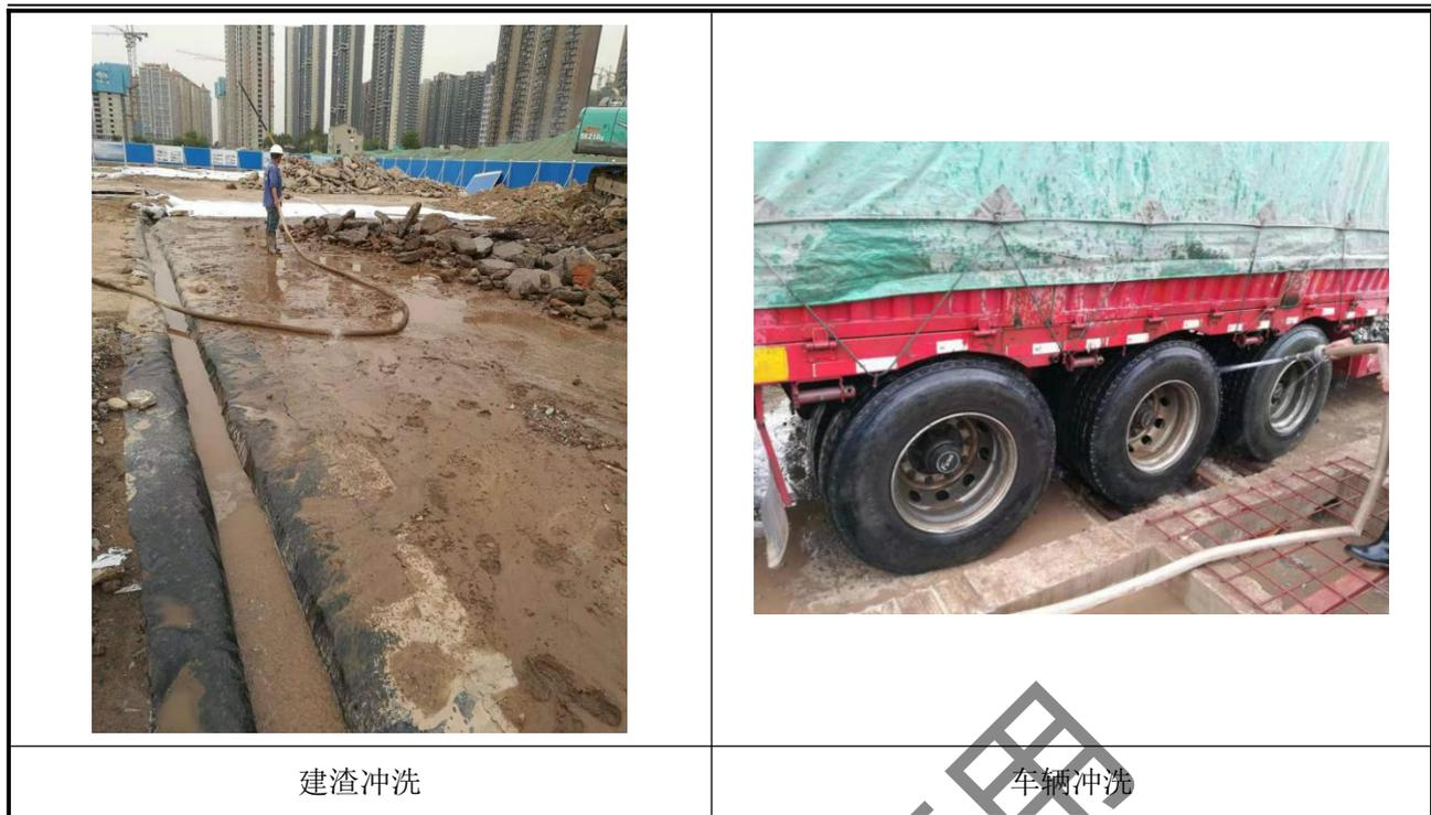
图 3-8-4 建渣冲洗和车辆冲洗相关照片
