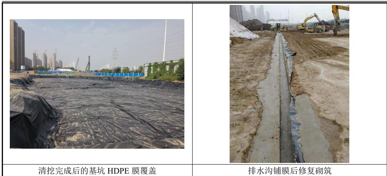
图 3-8-5 雨水处理措施相关照片
